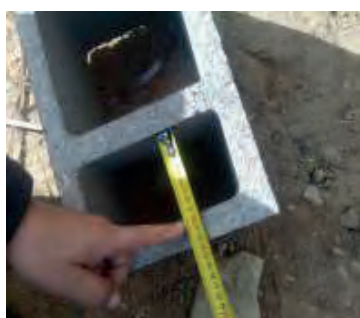
Non-respect des dimensions minimales des conduits individuels et collectifs-
