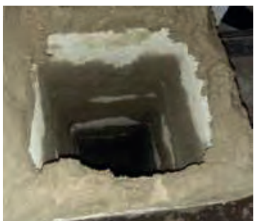
Absence de jonction selon un angle ouvert pour diriger les filets gazeux vers le haut
