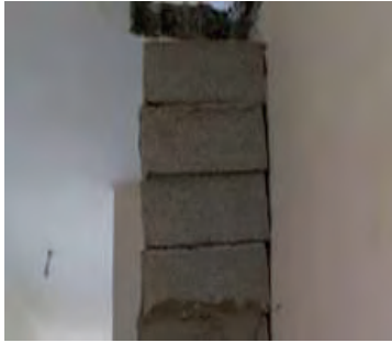
Insuffisance du mortier de jointement
