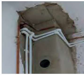
Fixation des conduits de gaz et d'eau sur les parois des conduits de fumée sans habillage en brique
