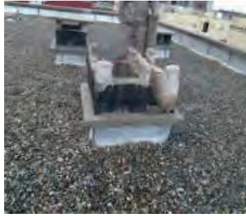
Non-respect des hauteurs réglementaires des débouchés des conduits
