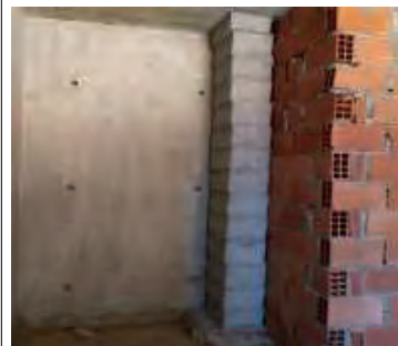
Absence de crépissage au mortier de ciment du côté postérieur des boisseaux
